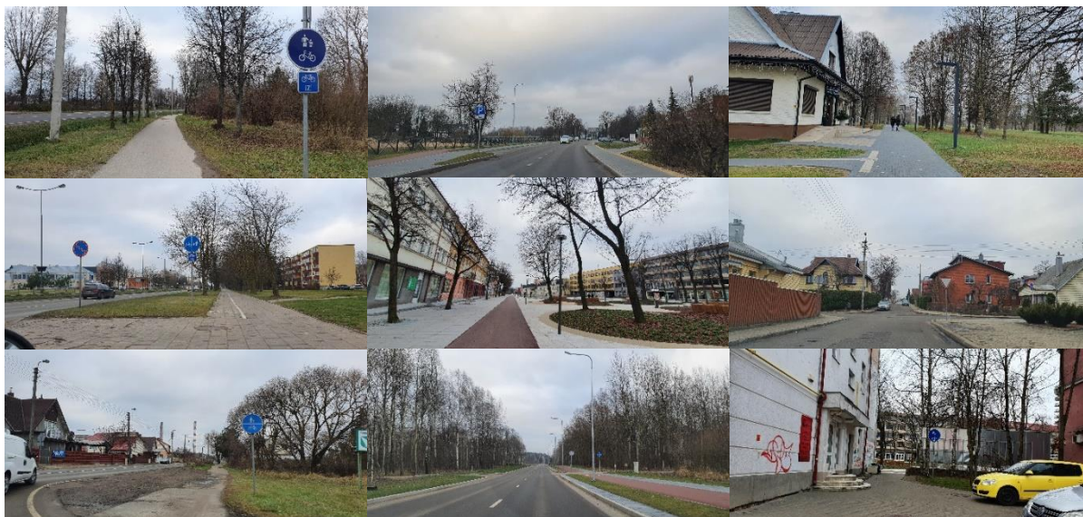
54 pav. Panevėžio dviračių takų būklė
