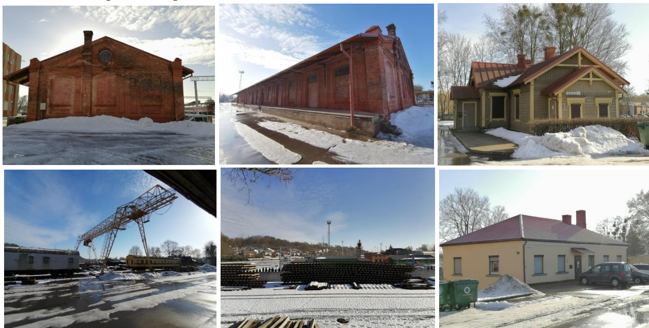
68 pav. Fotofiksacija. Rytinė Kauno geležinkelio stoties teritorijos pusė. Sandėliavimo pastatai, buvę geležinkelio darbuotojų pastatai, pramoninė zona, administraciniai pastatai
