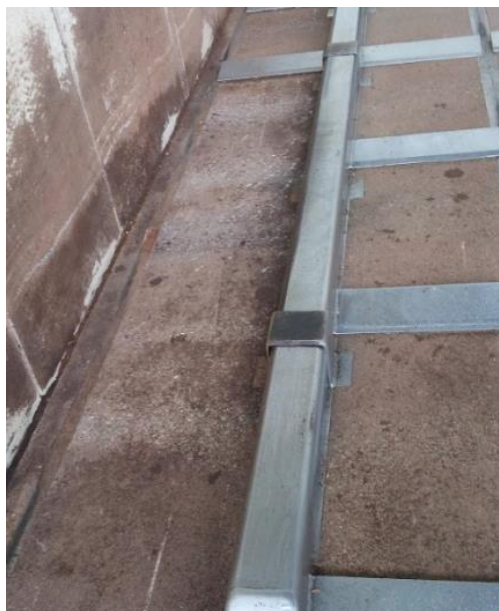
1.25 pav. Žertuvas su nulaužtais sparnais dėl jų deformacijos
