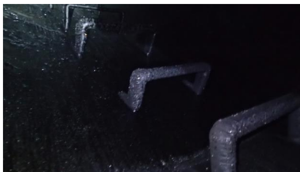
1.3 pav. kokso sankaupos ant kolonos kopetėlių. [1]
