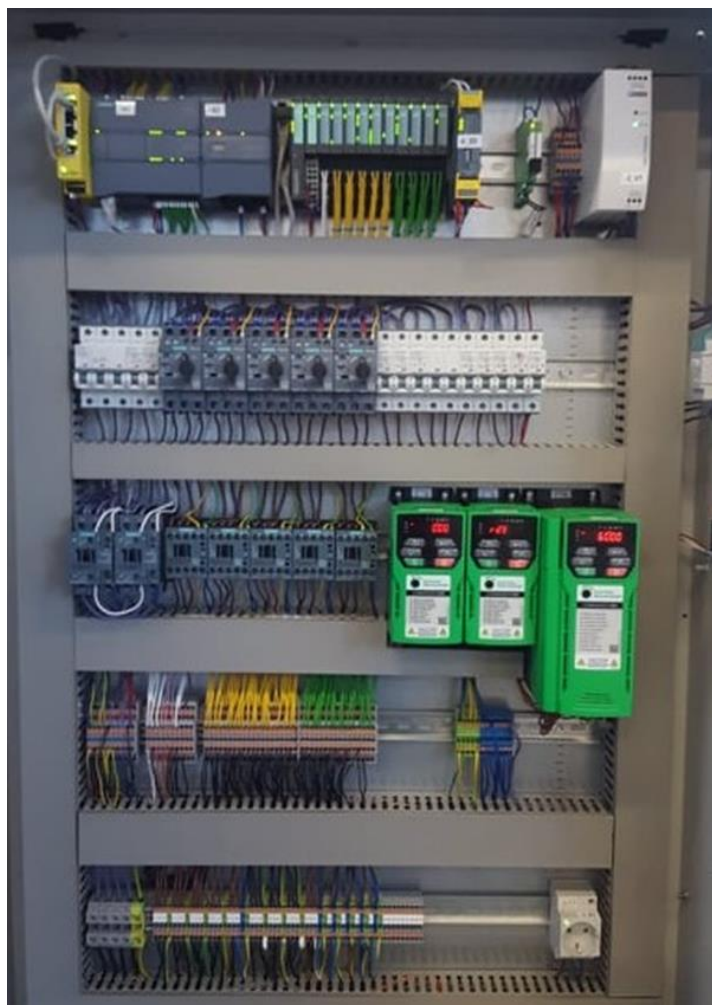
4.1 pav. Twist pack pakavimo mašinos valdymo skydas
