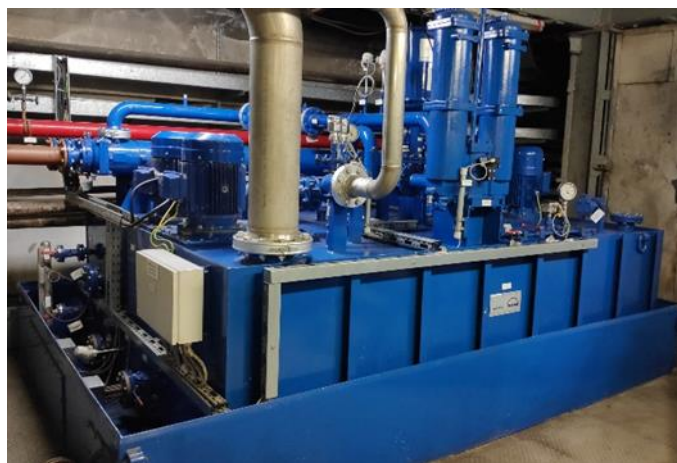
2 pav. Tepimo alyvos talpa, siurbliai, filtrai, šilumokaitis
