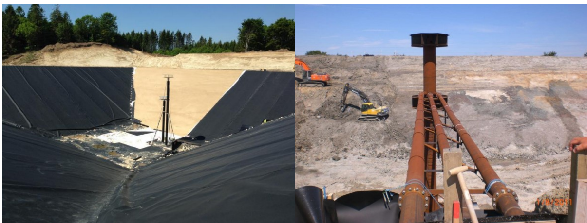
2.13 pav. Talpų įvadas ir išvadas su difuzoriais SUNSTORE 3 (kairėje) bei SUNSTORE 4 (dešinėje) projektuose
