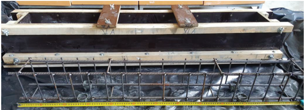
2.2 pav. Gelžbetoninių sijų klojinys ir armatūros karkasas
