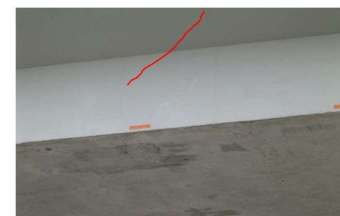
Iš kairės: 1.6 pav. Atsivėrę įstrižieji plyšiai; 1.7 pav. Sijų sienutėse atsivėrę įstrižieji plyšiai
