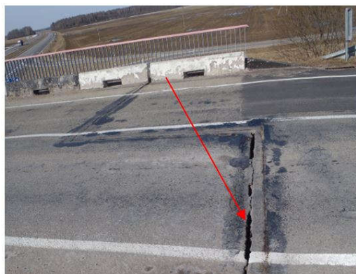
Iš kairės: 1.2 pav. Kiauri viadukų deformaciniai pjūviai virš pirmos atramos; 1.3 pav. Nelygi, banguota, nusidėvėjusi kelio danga
