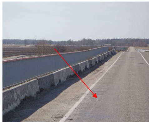
Iš kairės: 1.2 pav. Kiauri viadukų deformaciniai pjūviai virš pirmos atramos; 1.3 pav. Nelygi, banguota, nusidėvėjusi kelio danga
