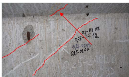
Iš kairės: 1.6 pav. Atsivėrę įstrižieji plyšiai; 1.7 pav. Sijų sienutėse atsivėrę įstrižieji plyšiai
