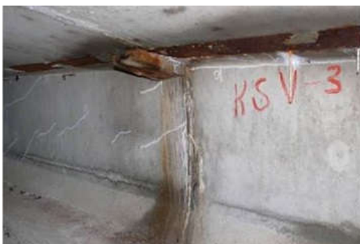
Iš kairės: 1.4 pav. Nesandari blokų sandūra; 1.5 pav. Viadukuose koroduoja vielapluoščiai, dalis jų nutrūkė
