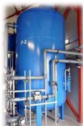
1 pav. Slėgio filtras [2]
