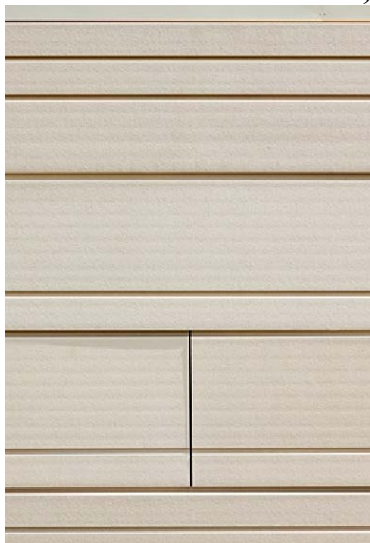
Paveikslas Nr. 11. „NBK architectural terracotta“ fasado apdailos plokštės
