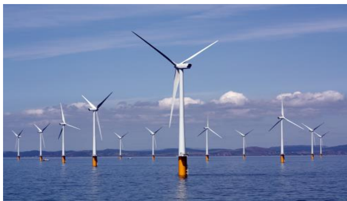
3.5 pav. Jūroje esantis vėjo elektrinių parkas. [19]
