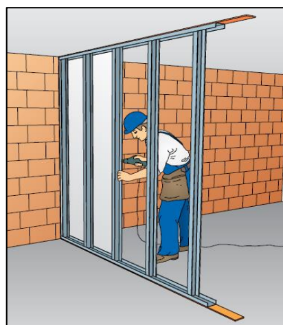
4.7 pav. Gipso plokštės montavimas
