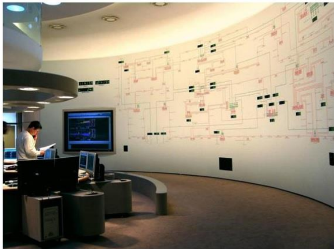
1 pav. Dispečerinio skydo su informacijos iš SCADA sistemos išvedimu ir videosienos integracija pavyzdys [3]
