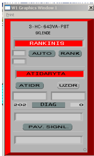
2.3 pav. HC643VA sklendės valdymo langas
