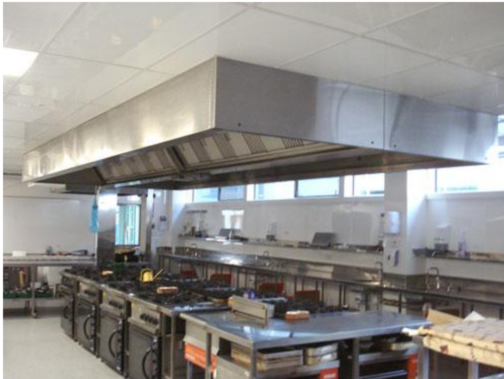
1.1 pav. Tipinė pramoninė virtuvė su centriniu garų rinktuvu [5]
