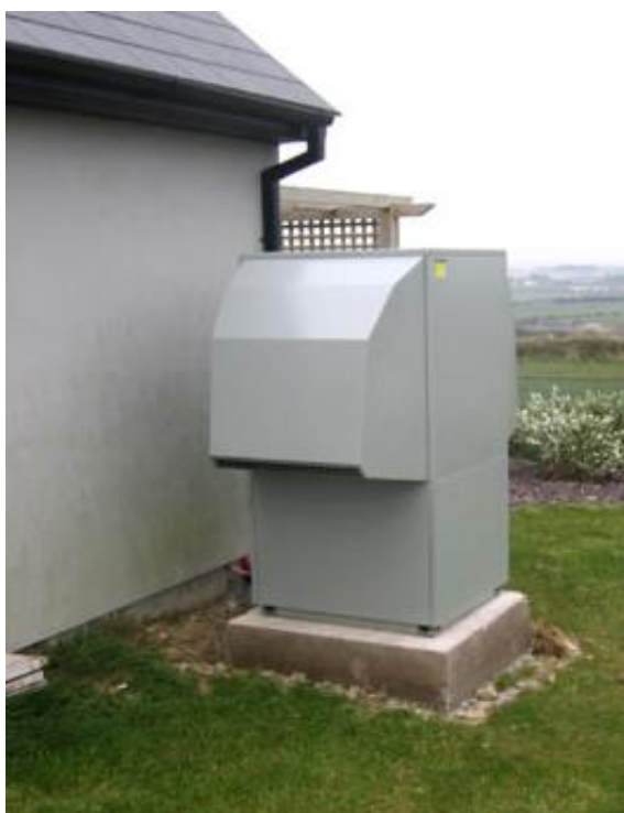
4.13 pav. Oras – vanduo šilumos siurblio lauko išpildymas
