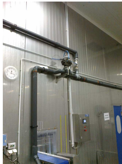
b) druskos koncentrato vamzdynas ir pneumatinė sklendė
