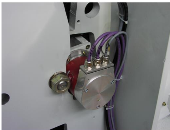
3.7 pav. absoliutinis enkoderis Profibus
