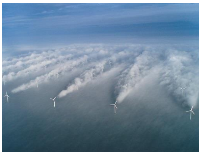
1.5 pav. Turbulencijos efektas už vėjo elektrinės vėjaračio [15]
