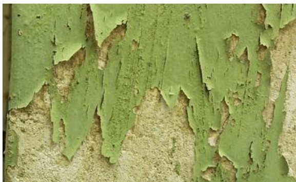
3 pav. Statybinės medžiagos su PCB
