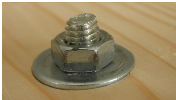
Pav 2.8 Suvaržymas srieginiais strypais
