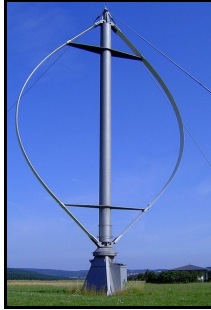
2.1.1. paveikslas. Vertikalios veleno ašies vėjo el.
