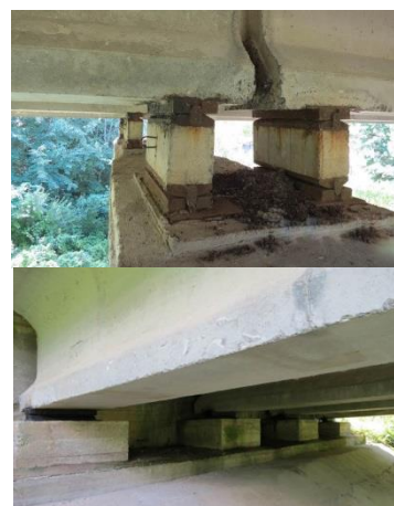
2.6 pav. Paslankių/nepaslankių atraminių guolių bendras vaizdas
