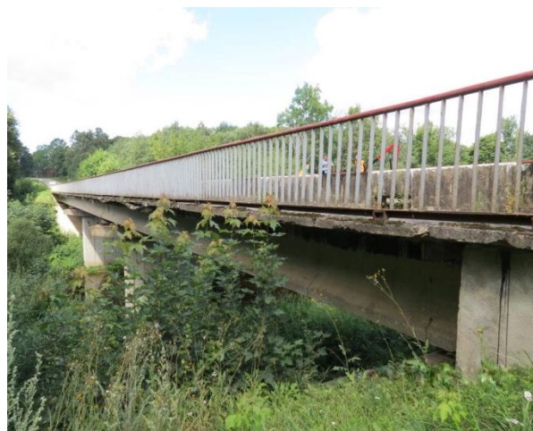
2.4 pav. Tiltu bendras vaizdas nuo žemupio pusės
