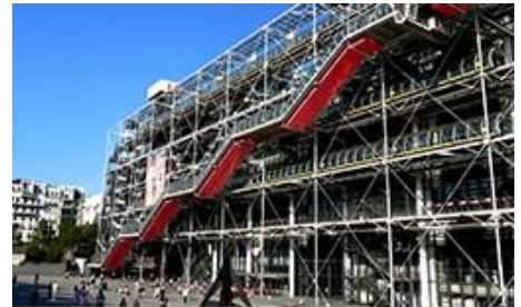
Atviros konstrukcijos ir inžinerinės komunikacijos
