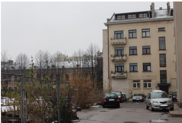
9. pav. Šalia sklypo esantis pastatas
