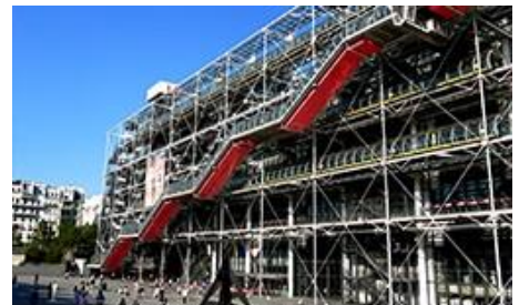
Atviros konstrukcijos ir inžinerinės komunikacijos
