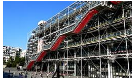
Atviros konstrukcijos ir inžinerinės komunikacijos
