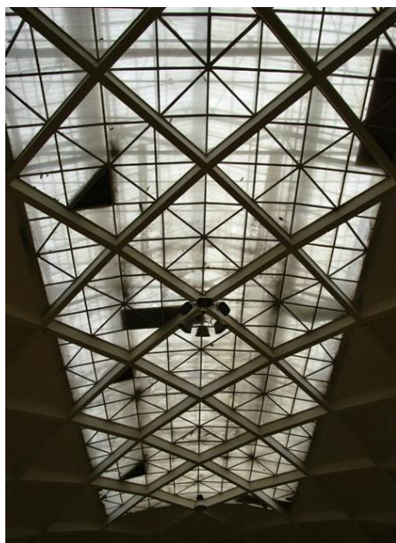
44 pav. LSU stiklinio stogo konstrukcija
