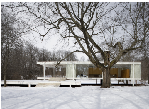
Pav. nr. 8 Farnsworth House
