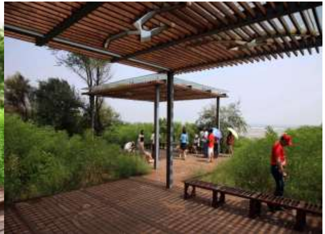
Pav. 13 „Qinhuangdao pavilionai 2“
