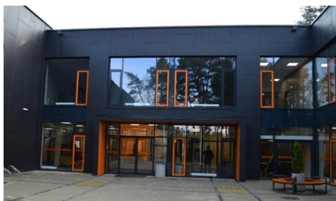
8 pav. Veršvų gimnazijos fasadas
