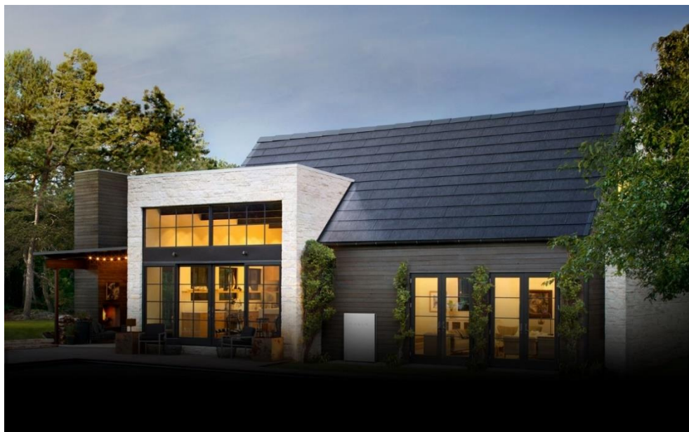
27 pav. Saulės elektrinė su integruotomis fotovoltinėmis celėmis į čerpes
