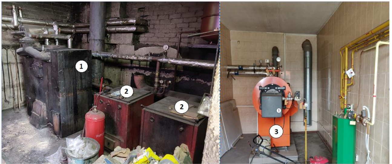
22 pav. Poilsio namų „Ažuolynas“ katilinės esama būklė.
