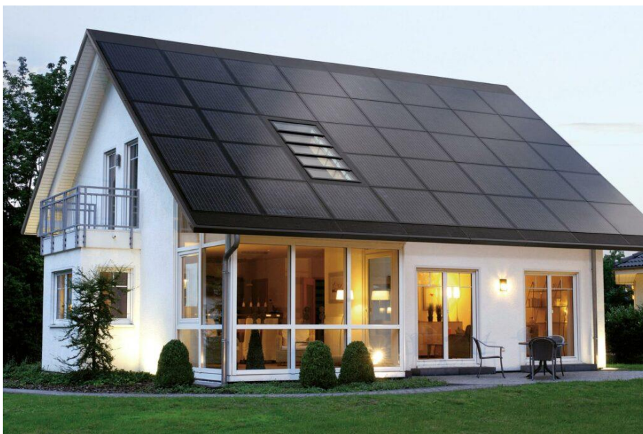
25 pav. Saulės elektrinė integravama į stogo dangą
