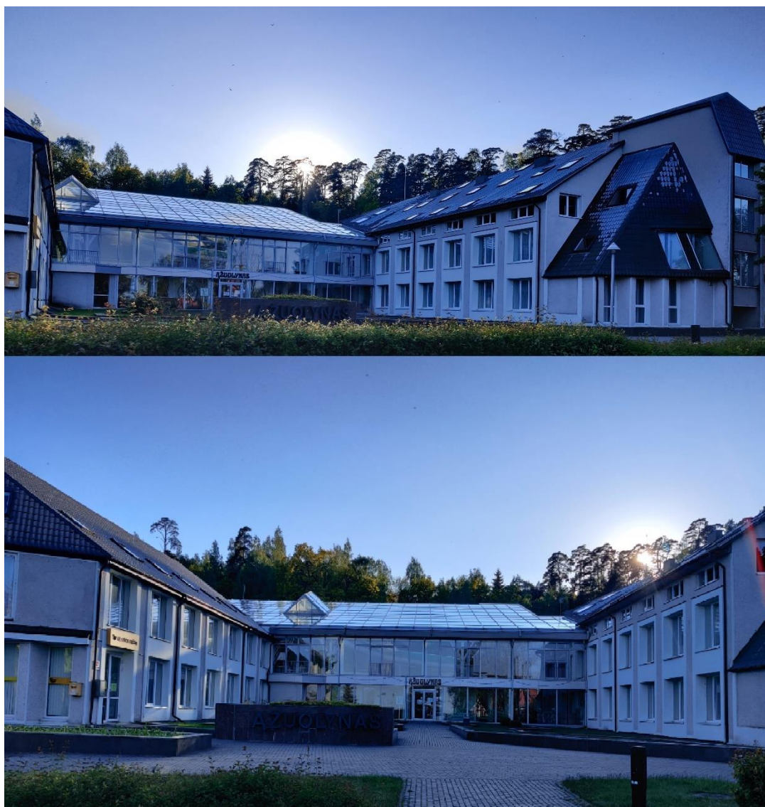
21 pav. Tiriamąo objekto - poilsio namų „Ažuolynas“ rytinio fasado esama būklė
