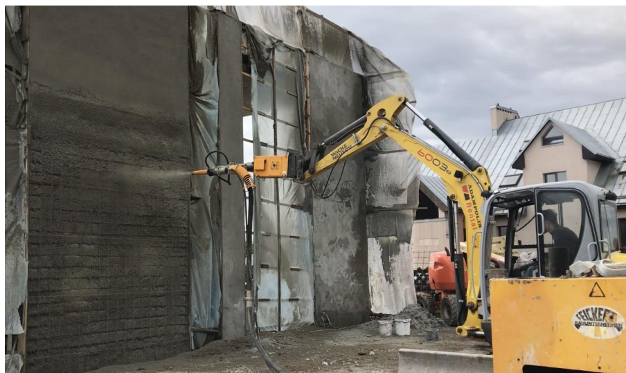
3 pav. Torkretavimas nuotoliniu būdu valdomu purškimo įrenginiu
