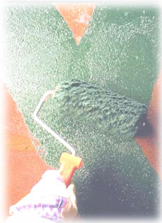
3.2.2 pav. Grunto dangos dengimas voleliu [11]
