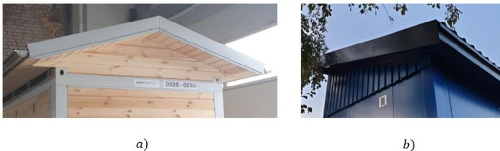
5 pav. Stogų tipai: a) dvišlaitis; b) vienslaitis
