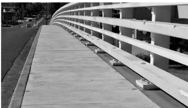
3 pav. Gelžbetoninis pėsčiųjų takas [42]
