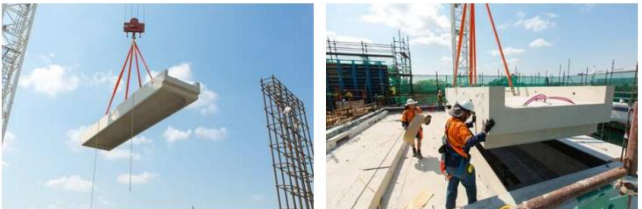
6 pav. Perdangos plokštės pagamintos iš šarmu aktyvuotų medžiagų montavimas [43]
