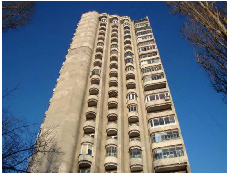
5 pav. Šarmu aktyvuoto metalurginio šlako betonas panaudotas daugiabučio laikančiosiose konstrukcijose [1]
