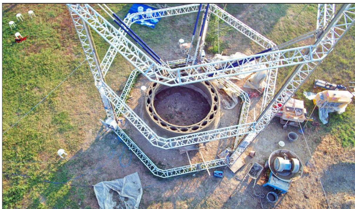
7 pav. Namo statyba stalybos aikštelėje su kabeliniu 3D spausdintuvu
