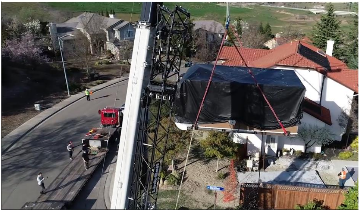
2 pav. Namo perkėlimas
