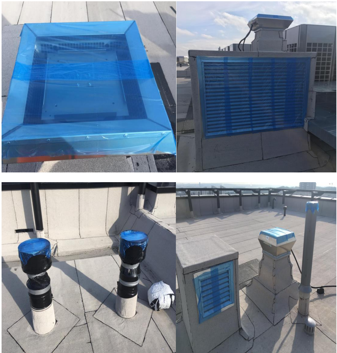
7 pav. Užsandarintos vėdinimo angos [Iš autoriaus asmeninio albumo]
