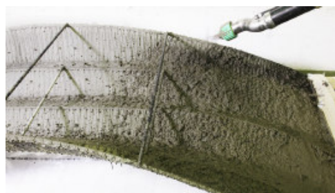
12 pav. Tinko formų klojinių betonavimas torkretavimo būdu [19]
