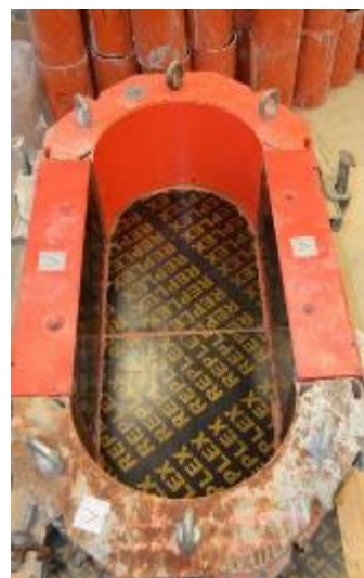
43 pav. Surinkti PERI klojiniai prieš betonavimą
