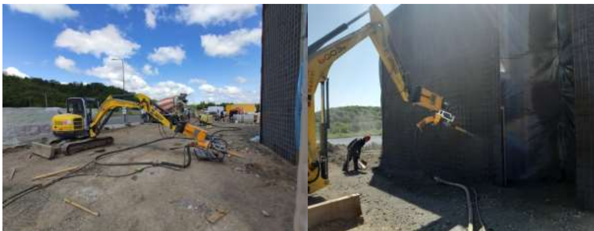
37 pav. a) ir b) Torkretavimo įranga sumontuota ant savaeigės statybos mašinos
