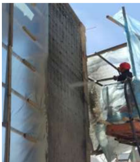
36 pav. „Šlapiojo tokretavimo būdas“, tūtoje sumaišomas betono mišinys su rišimąsi greitinančia įmaiša
