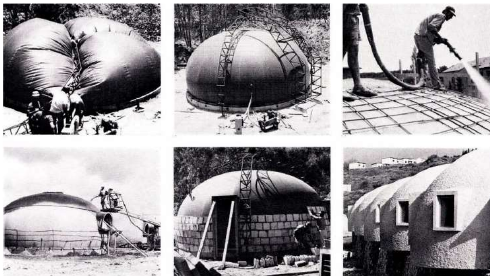
6 pav. Heifetzo išrastas „Domecrete“ konstrukcijos metodas [2].
