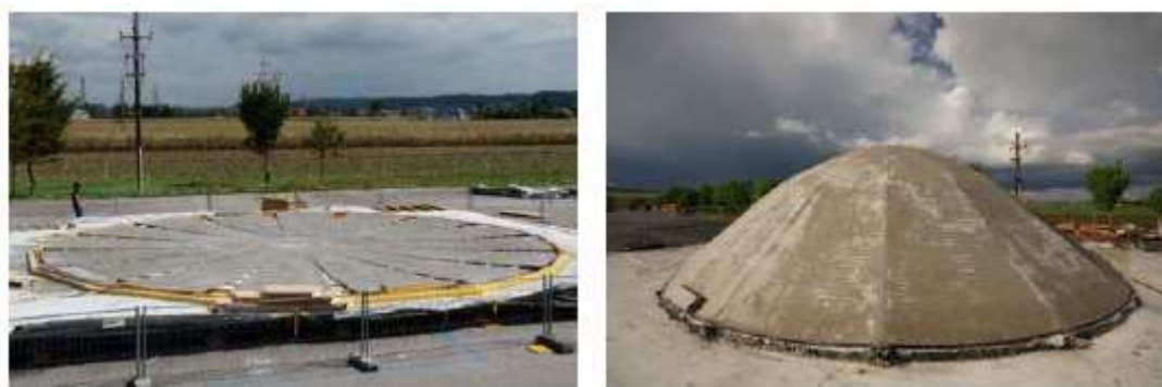
15 pav. Eksperimentas Austrijoje: sferinio apvalkalo pastatymas naudojant PFHC metodą [7].
