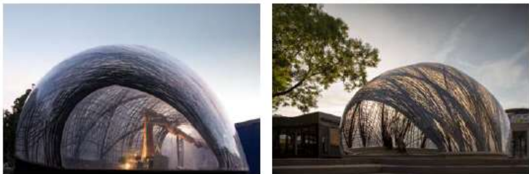
10 pav. Pripūstas paviljonas, sustiprintas anglies pluoštais, kurie užpurškiami roboto pagalba [5, 43].
