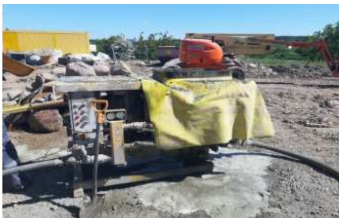
35 pav. Betono mišinio padavimo į tūtą siurblys
