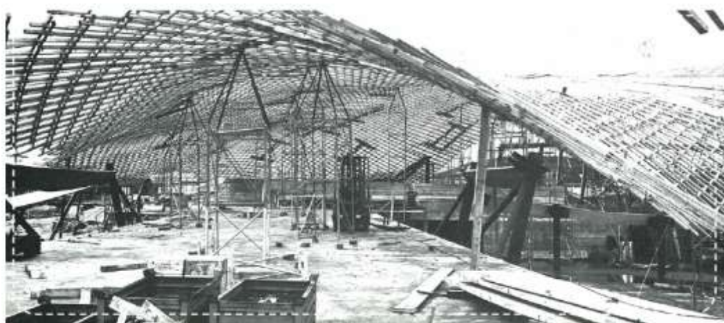
24 pav. Manheimo tinkelio konstrukcija [11].
