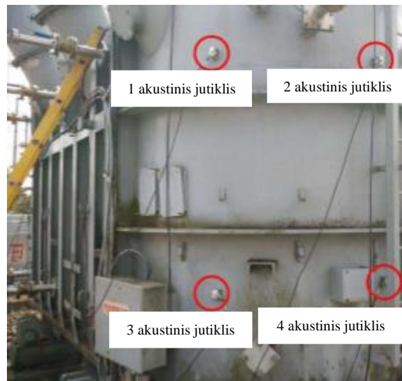
10 pav. Akustiniai jutikliai ant transformatoriaus [23]
