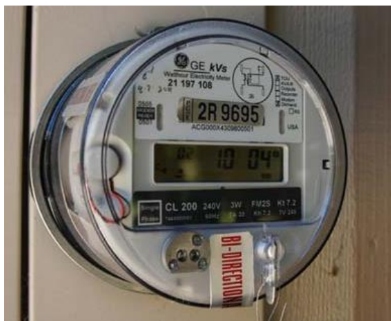
1.8 pav. Dvipusė elektros energijos apskaitos fiksavimo prietaisas [15]
