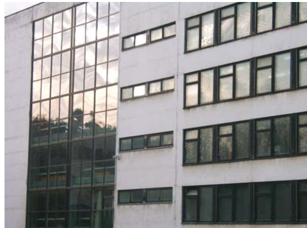
4 pav. KTU Cheminės technologijos fakulteto rūmai, detalė. Archit. V. Dičius, 1970 m. Kaunas, Radvilėnų pl. 19 Fig 4. Fragment of KTU Faculty of Chemical Technology. Arch V. Dičius. 1970. Kaunas, Radvilėnai rd 19
