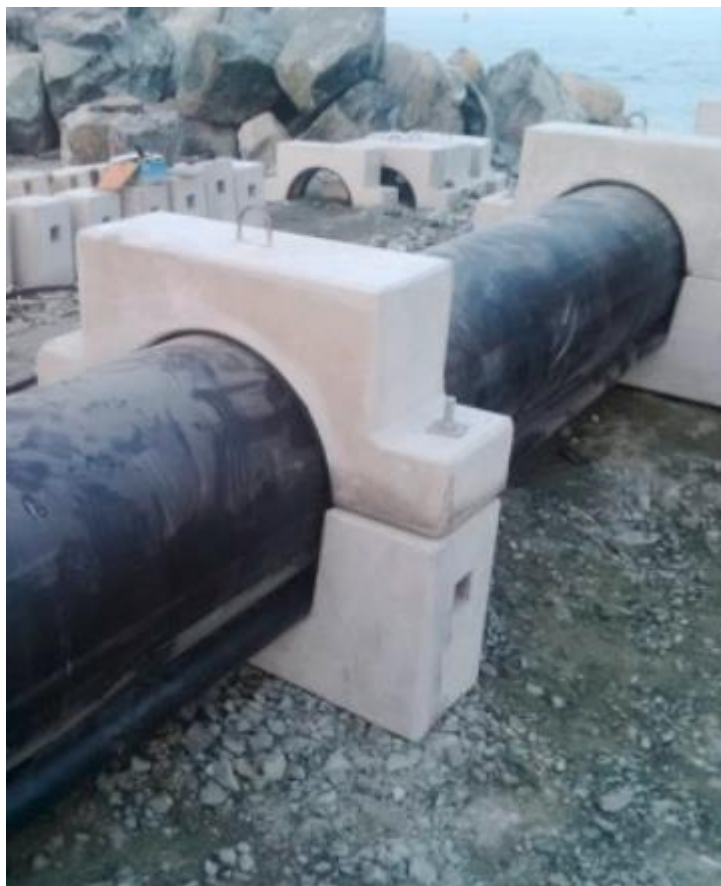
1 pav. HDPE inkarai, skirti panardinti vamzdžiams į jūros dugną
