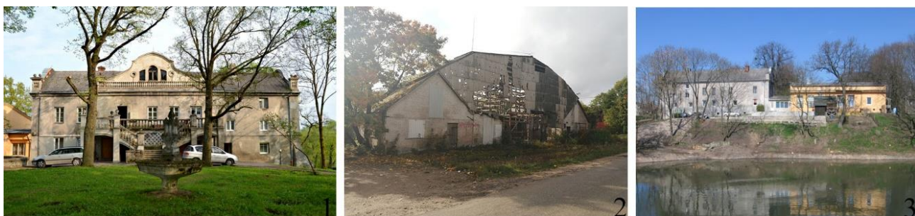
49 pav. Esamų pastatų fizinės būklės fotofiksacijos
