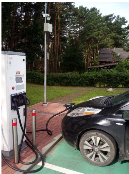
1.5 pav. ABB elektromobilių greitojo įkrovimo stotelė
