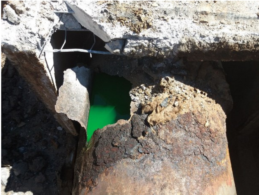
5 pav. Termofikacinio vamzdžio avarijos nuotrauka
