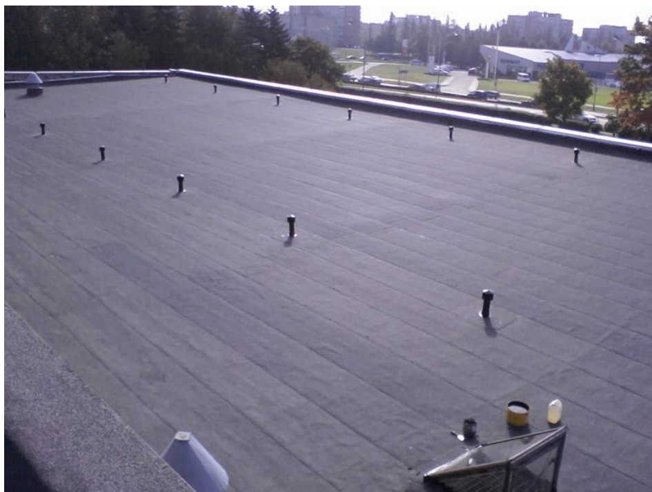
6 pav. Plokščiasis neeksploatuojamas stogas su ritinine danga
