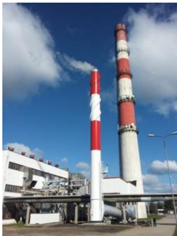
2 pav. Plieninis kaminas šalia gelžbetoninio kamino
