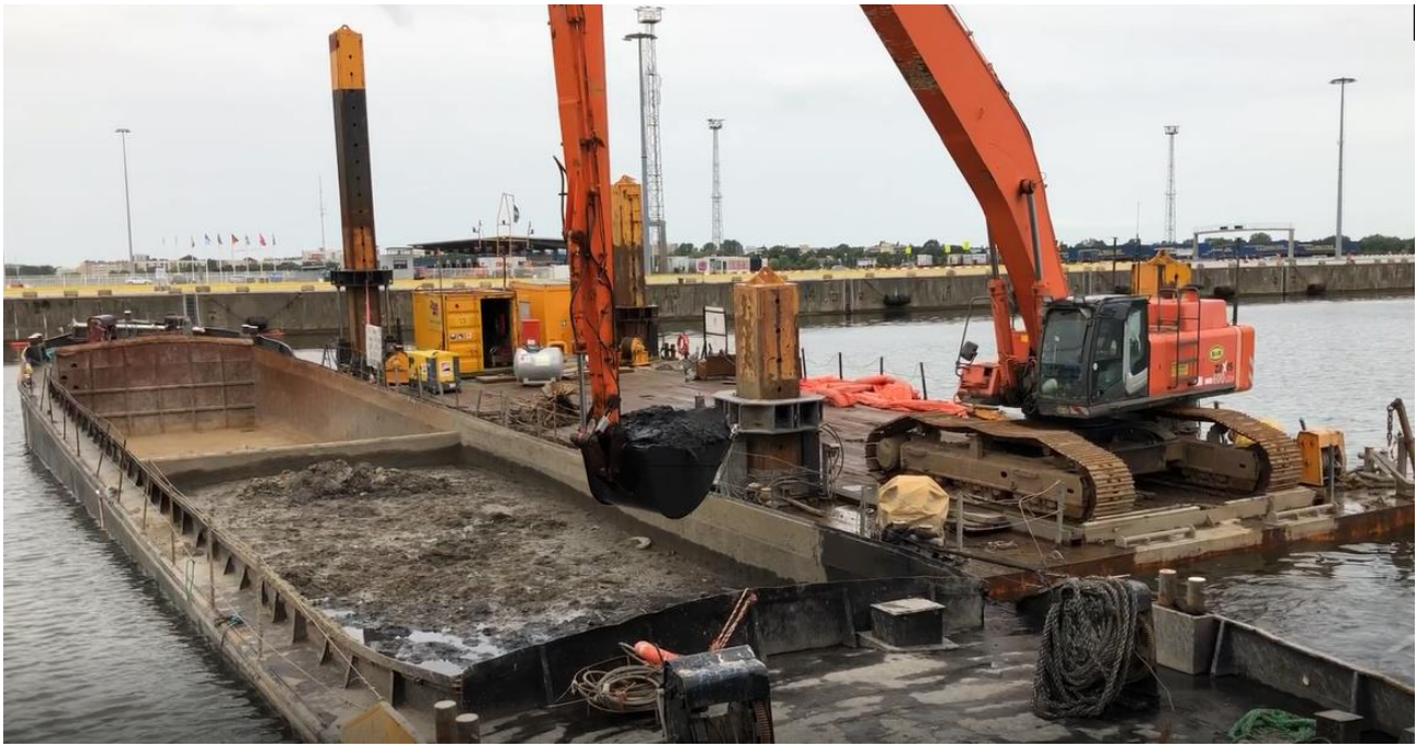
2 pav. Bremeno uosto užteršto grunto panaudojimo kratinių sutvirtinimui darbai
