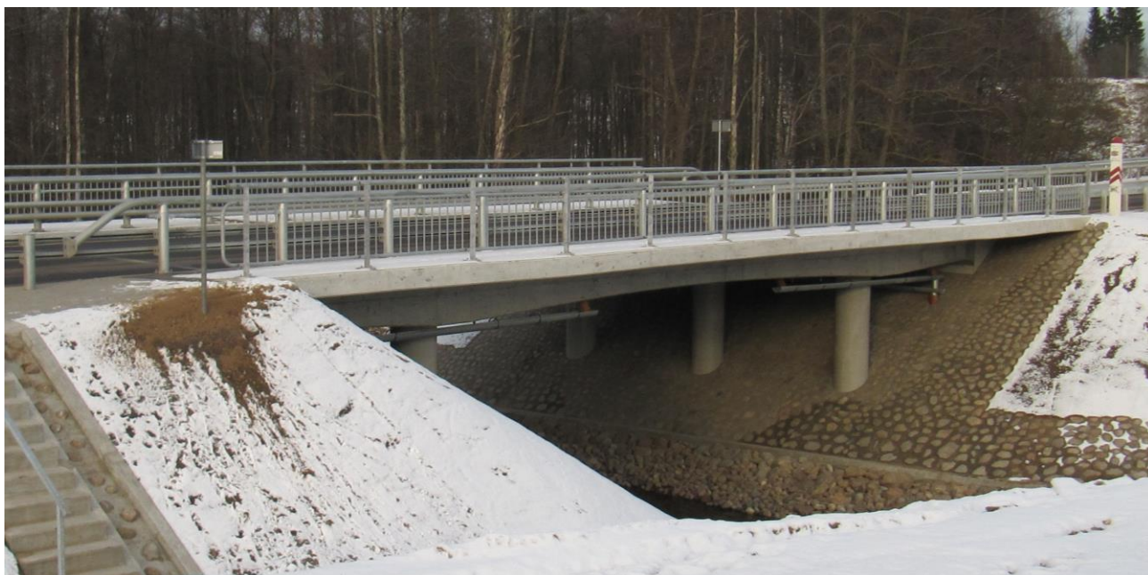
6 pav. Tiltas su plokštine perdanga
