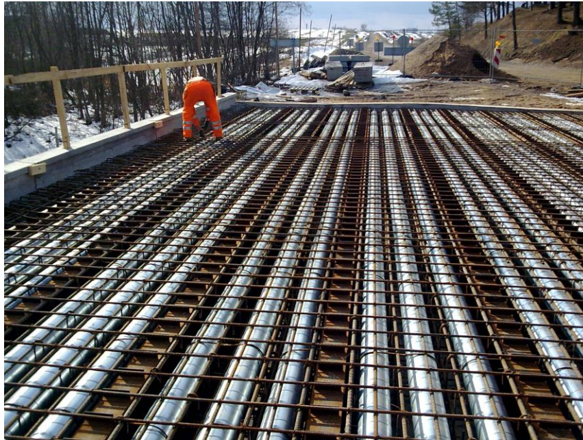
7 pav. Kompozitinės perdangos įrengimas
