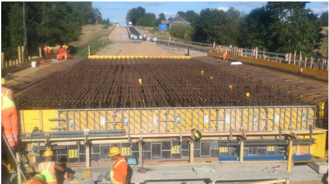
5 pav. Pasiruošimas ištisiniam tilto perdangos betonavimui
