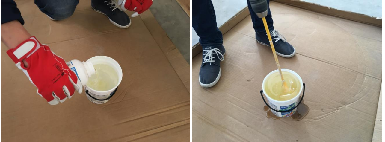
Pav. 8. Naudotas gruntas ir jo paruošimas
