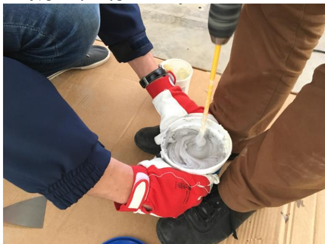
Pav. 9. Naudoti klijai ir jų paruošimas
